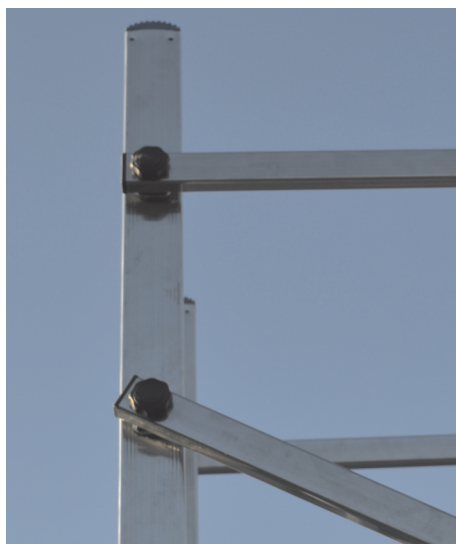
Correnti orizzontali e diagonali con pomelli di sicurezza. Horizontal and diagonal braces connecting with safety knob
